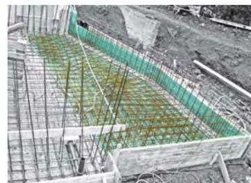
Aislamiento térmico FIBRANxps 400 - L bajo losa de cimentación en una piscina climatizada
