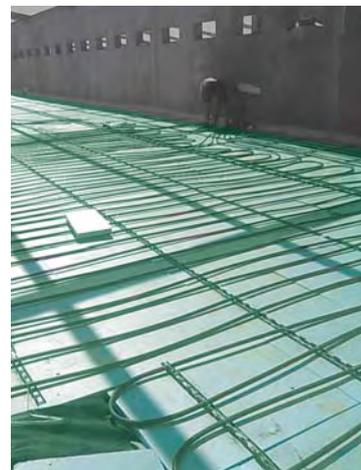
Aislamiento térmico FIBRANxps 200 - I bajo suelo radiante
