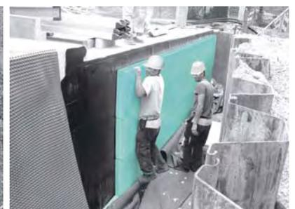
Fijación de las placas FIBRANxps 300-L en la membrana de impermeabilización del cerramiento con adhesivos FIBRANstick.
