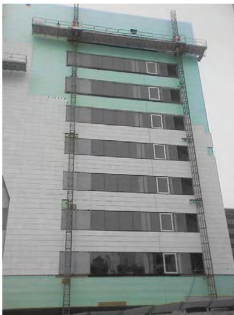
Fijación de aislamiento FIBRANxps **MAESTRO** con fijadores FIBRANxps
