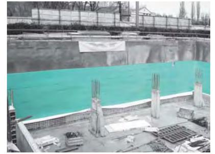
Protección térmica de paredes Jet – suelo con FIBRANxps 300-L construcción inversa de una pared de sótano
