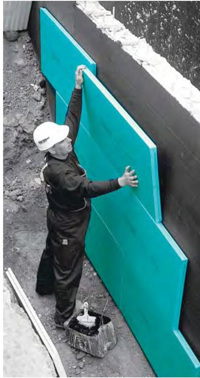
Protección mecánica de la membrana de impermeabilización y al mismo tiempo aislamiento térmico del sótano con FIBRANxps 300-L
